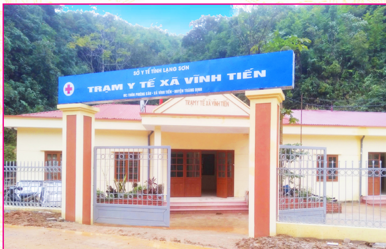
Trạm y tế xã Vĩnh Tiến
